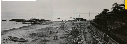
工事中の興津防波護岸(1962年)
