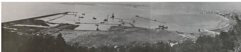
工事中の興津第1埠頭 (1965年)
