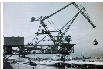
石炭岸壁に石炭荷役用アンローダー1号機を設置 (1958年)
