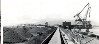
石炭岸壁と貯炭場 (1960年)
