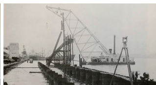
村松岸壁 鋼管杭の打設工事 (1962年)
