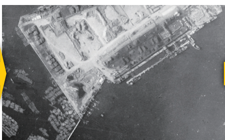
完成後の石炭岸壁 (1962年)
