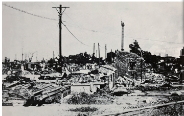
旧市役所付近
