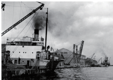
日の出岸壁と5号上屋(1950年)
