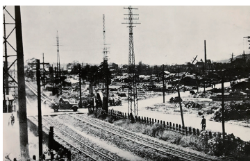
江尻踏切付近
