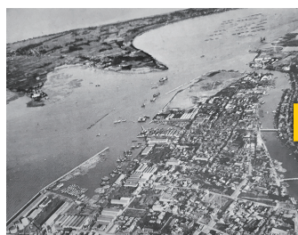
修築工事中の清水港 (1924年)
