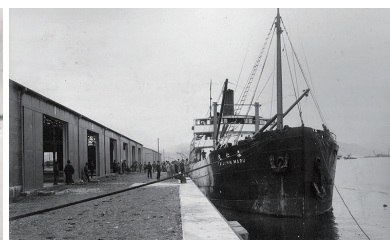
丙岸壁に第1船「泰仁丸」が入港(初の接岸荷役) (1929年5月)
