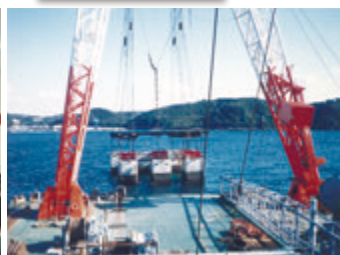
消波ブロック内蔵双胴型ケーソンの据付作業 (1998年)
