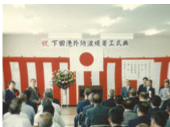
下田港防波堤着工式典 (1985年9月7日)
