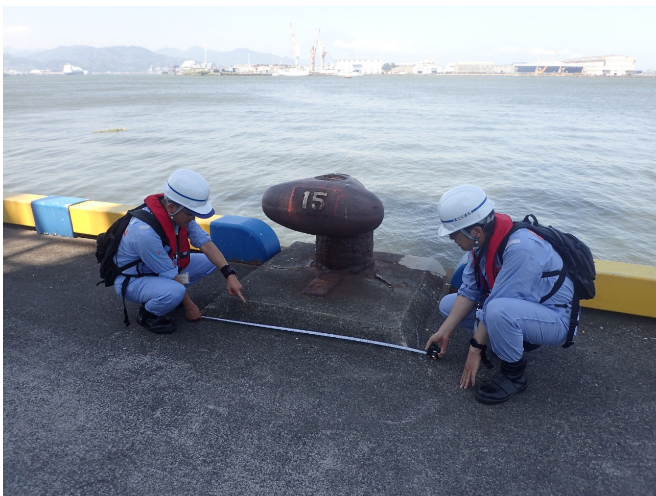
施設点検の状況
