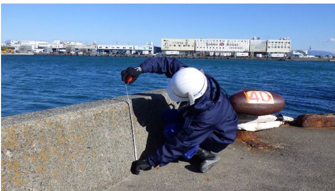
施設点検の状況
