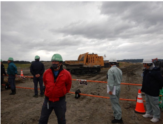
写真②：浚渫土砂を運搬している状況（中央：不整地運搬車）
