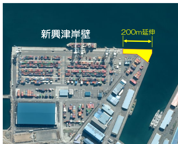
＜新興津岸壁延伸事業の概要＞
