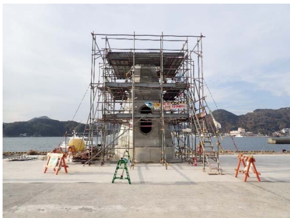
<灯台製作状況>
