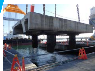
大型起重機船で 岸壁上部を撤去
