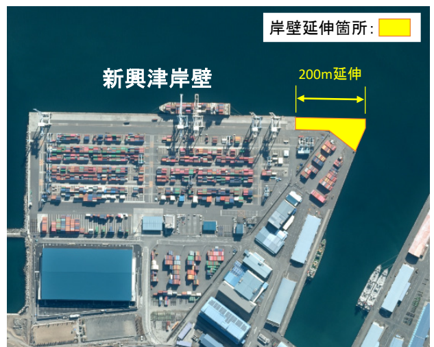
<新興津岸壁延伸事業の概要>
