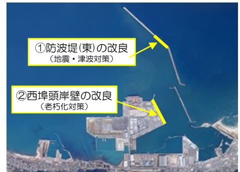
<御前崎港の事業箇所>
