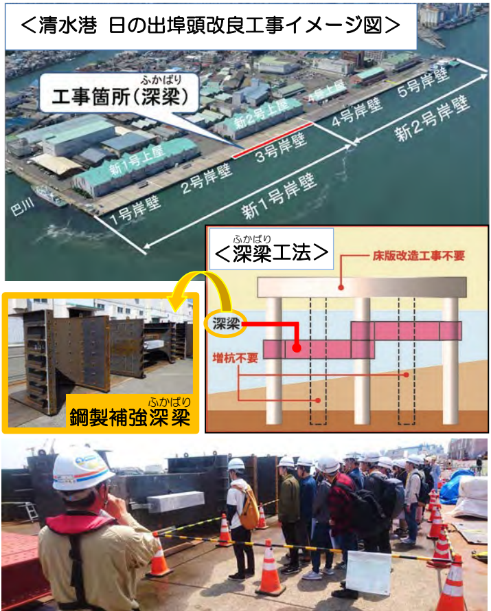
<岸壁改良工事現場を見学>
