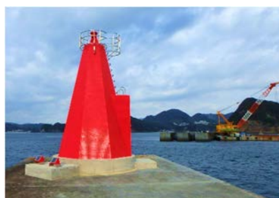
＜新灯台(手前)と仮灯台撤去(奥)の様子＞
