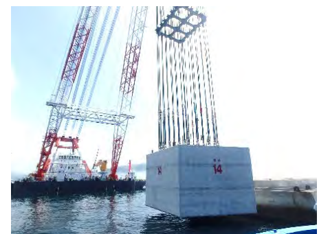
<大型ブロック据付状況>
