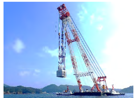
<起重機船「富士」での移動状況>
