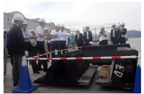
＜日の出岸壁の改良事業説明の様子＞
