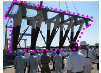
ジャケットの大きさは、幅約38m、高さ15mあり、重さはジャンボジェット機とほぼ同じ大きさです。
