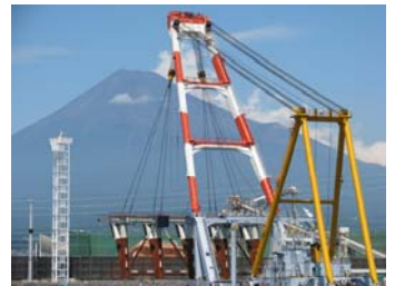
700トン吊の大型クレーン船で、据付作業を行います。
