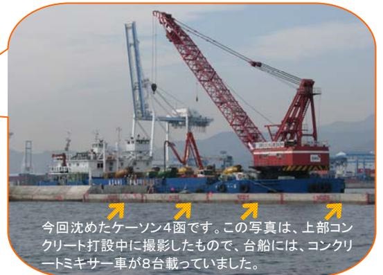
今回沈めたケーソン4函です。この写真は、上部コンクリート打設中に撮影したもので、台船には、コンクリートミキサー車が8台載っていました。
