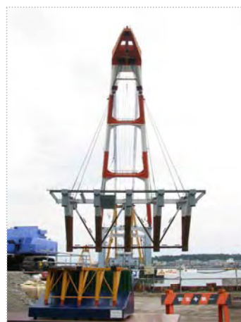
クレーン船「大和」に吊り上げられたジャケット全景
