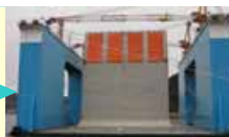
約5,000トンのケーソンが完成
