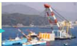
FDに注水すると、FDが沈みケーソンが浮き上がってきます。
