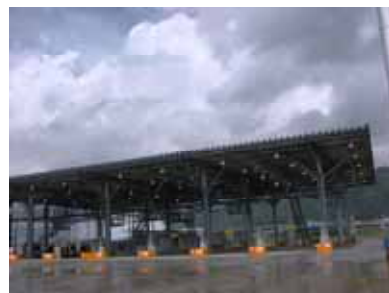
平成19年8月にオープンした新興津ゲート
