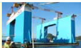
海に浮かぶフローティングドック(以下、FD)の上でケーソンを製作します。
