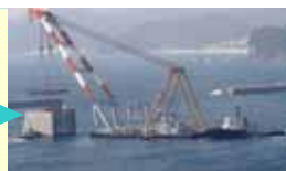
ケーソンは、浮いたままクレーン台船で防波堤まで運ばれます。
