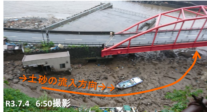
【写真①】 大量の土砂が流入・堆積した船揚場
