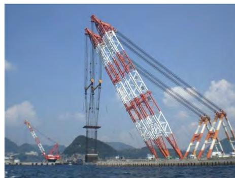
「ブロックを吊り上げたまま防波堤まで運び、防波堤の基礎部分(水中)へ据付」
