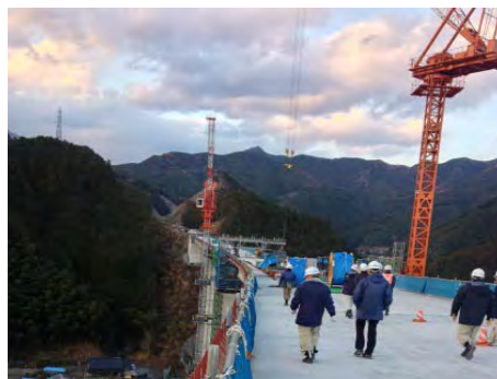
橋梁工事現場の様子
