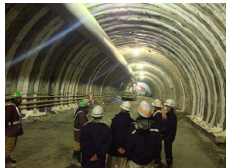
トンネル工事現場の様子
