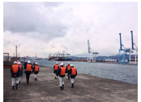
防波堤工事現場の様子
