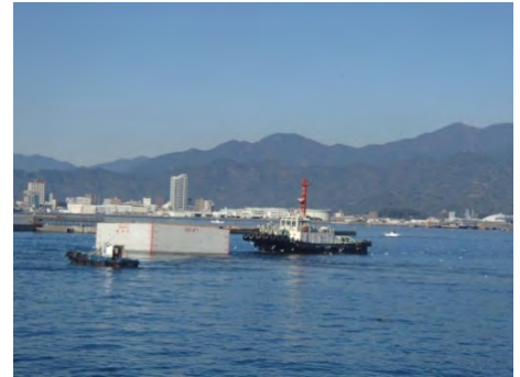
ケーソン曳航作業
