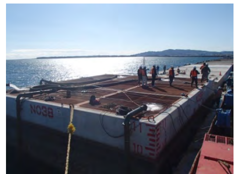
ケーソン据付作業
