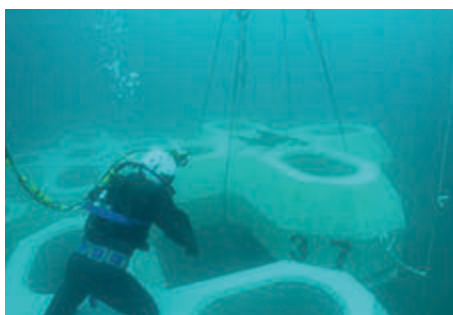
防波堤(東) 16t型被覆ブロックの据付作業 (2021年2月)
