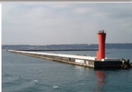
防波堤(西) 上部工の嵩上げ後 (2018年1月)
