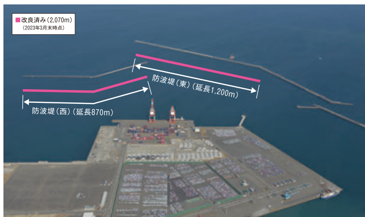
防波堤の改良状況
