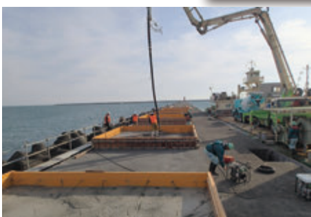
防波堤(西) 上部工の嵩上げ工事 (2017年11月)
