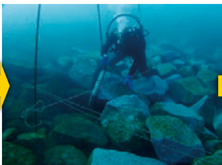
潜水士による石材の均し作業 (2021年1月)
