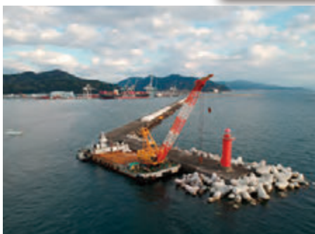
80t型消波ブロックの据付作業 (2020年12月)
