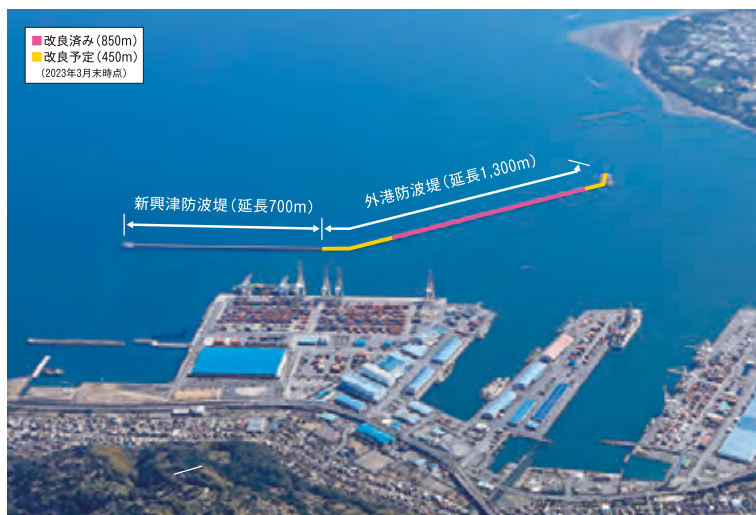
防波堤の改良状況
