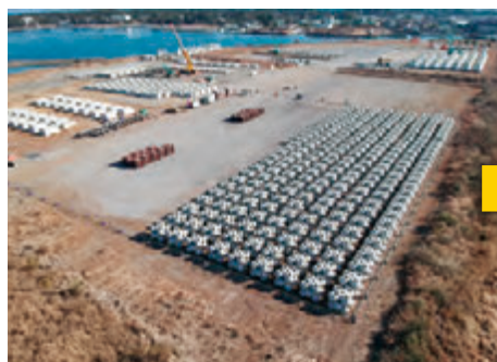
被覆ブロックの製作状況 (2021年1月)
