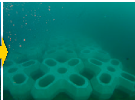
被覆ブロックの据付後 (2021年3月)
