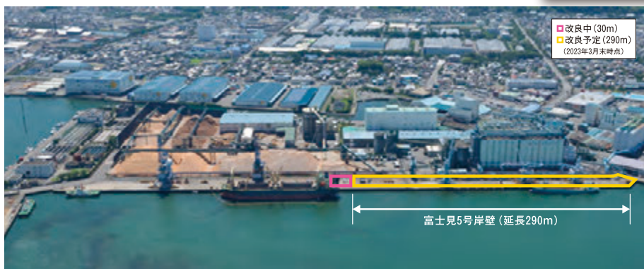
富士見岸壁の改良状況
